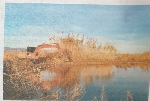
Excavadora trabajando ayer en una de las motas. ■ LRP
